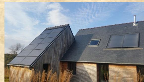
Une maison rénovée 200 000€ de travaux
